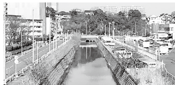
黒砂水路 水路奥は地下に埋められています
